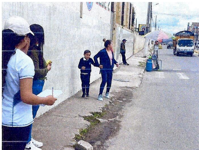
Figura 4. Acera con ancho insuficiente (Cuartel)
