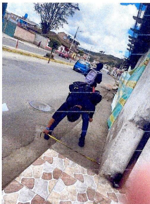
Figura 5. Acera con ancho insuficiente, (Av. Veintimilla y Buena Vista)
