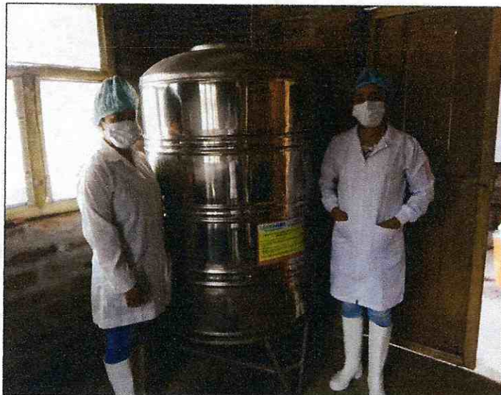
Limpeza del tanque de almacenamiento
